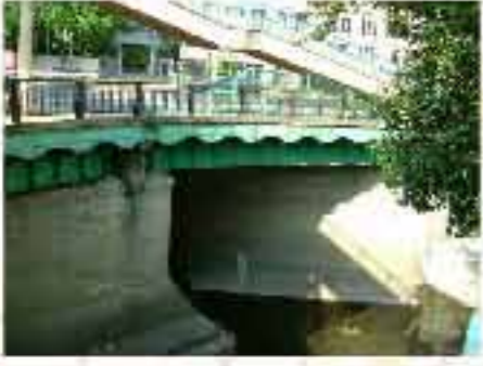
天現寺橋の下に現れる筈川合流口
